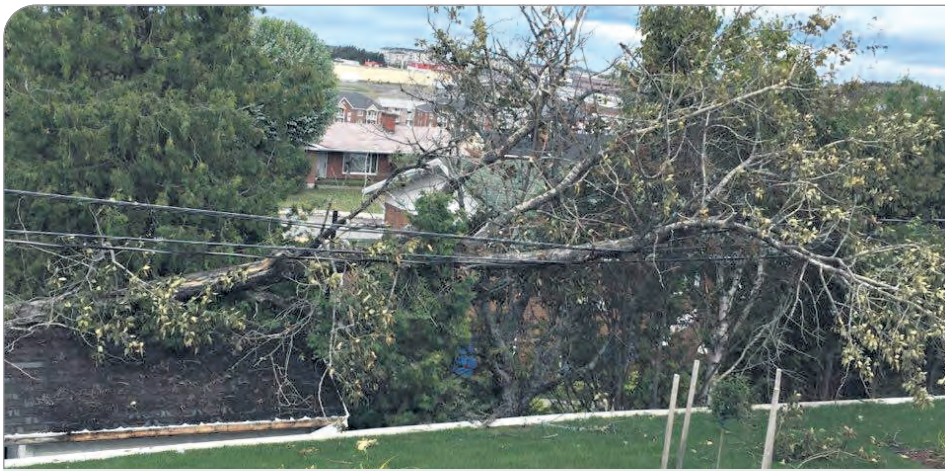
L'arbre s'est effondré sur les fils.
